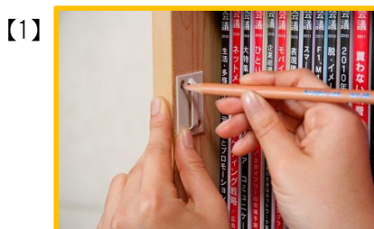
取り付け箇所に印を付け下穴を開けます
